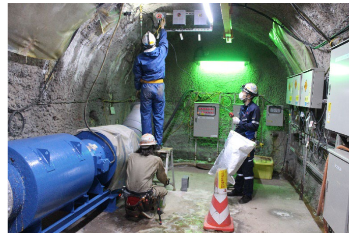
140m調査坑道 東側第1ボーリング横坑 (令和4年5月24日撮影)
