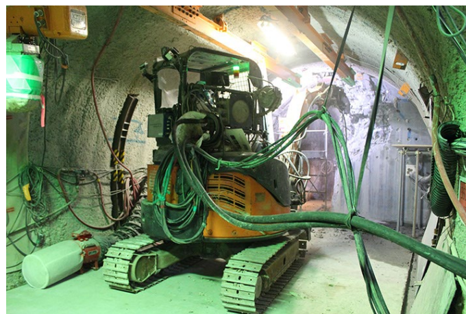
350m調査坑道 試験坑道1 (令和3年11月24日撮影)
