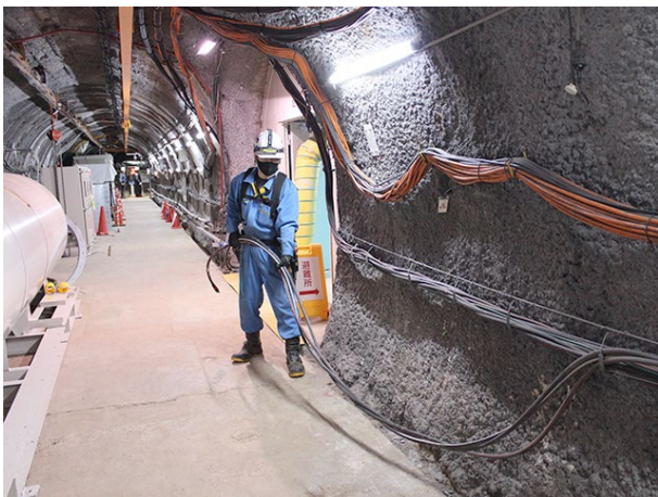
250m調査坑道 西連絡坑道 (令和4年12月13日撮影)
